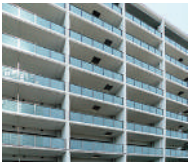
コロナ禍後の反動から、住宅需要の多様性、建築資材・建築費の高騰、人件費
